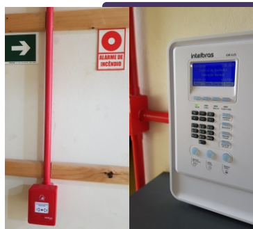
Instalação de sistemas de alarme de incêndio
