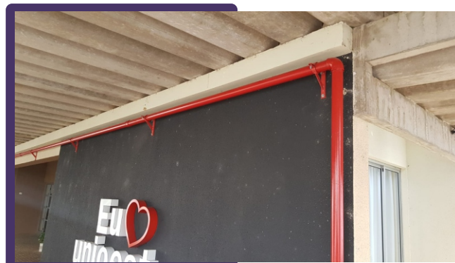
Instalação de hidrantes para o Restaurante Universitário e Auditório Carlos Maes
