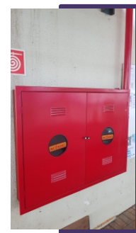
Instalação de hidrantes para o Restaurante Universitário
